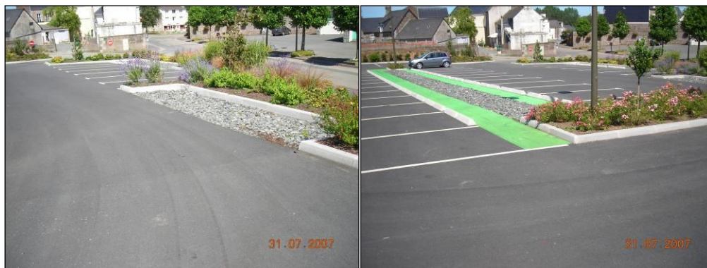
Photo 4 : Exemple de tranchées drainantes
